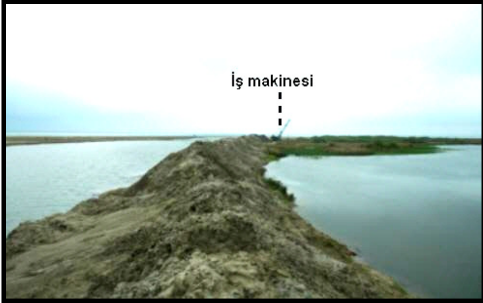
Foto 2. Balık göllerinin seviyesini kontrol amacıyla göl gideğininin temizlenmesi.
